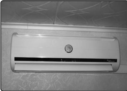
**FIGURA 9. Los sistemas de acondicionamiento de aire para interiores deben ser calculados en función del volumen de la habitación, en metros cúbicos.**
