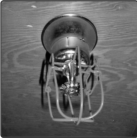
**FIGURA 12. Un rociador (sprinkler) es un dispositivo para extinción de incendios, que libera una lluvia de agua sobre la zona afectada.**
