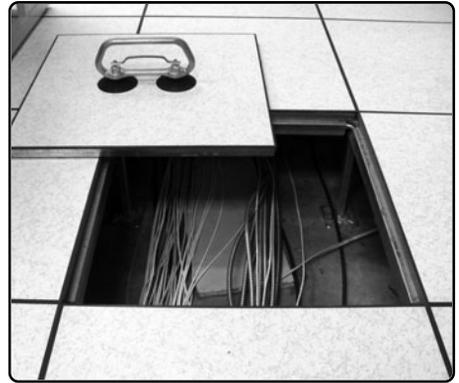
**FIGURA 10. El piso técnico permite pasar cables de electricidad y datos por debajo de él.**
